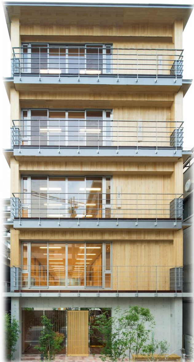
CLT工法の木造5階建て福祉ビル
